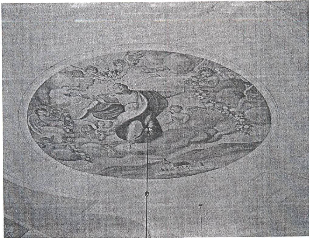
Fot.10 Plafon na suficie.
