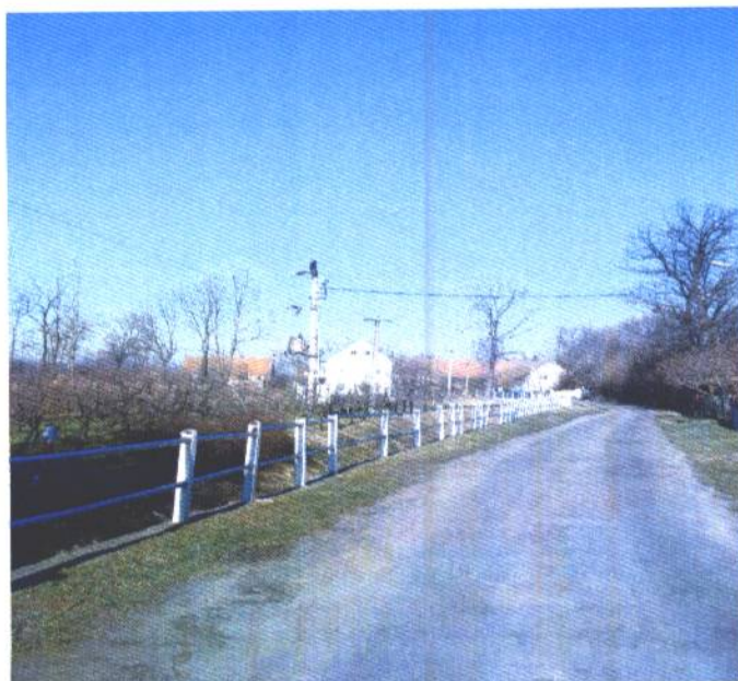
Fot. 2 Droga w Płonicy wzdłuż rzeki Świda.
